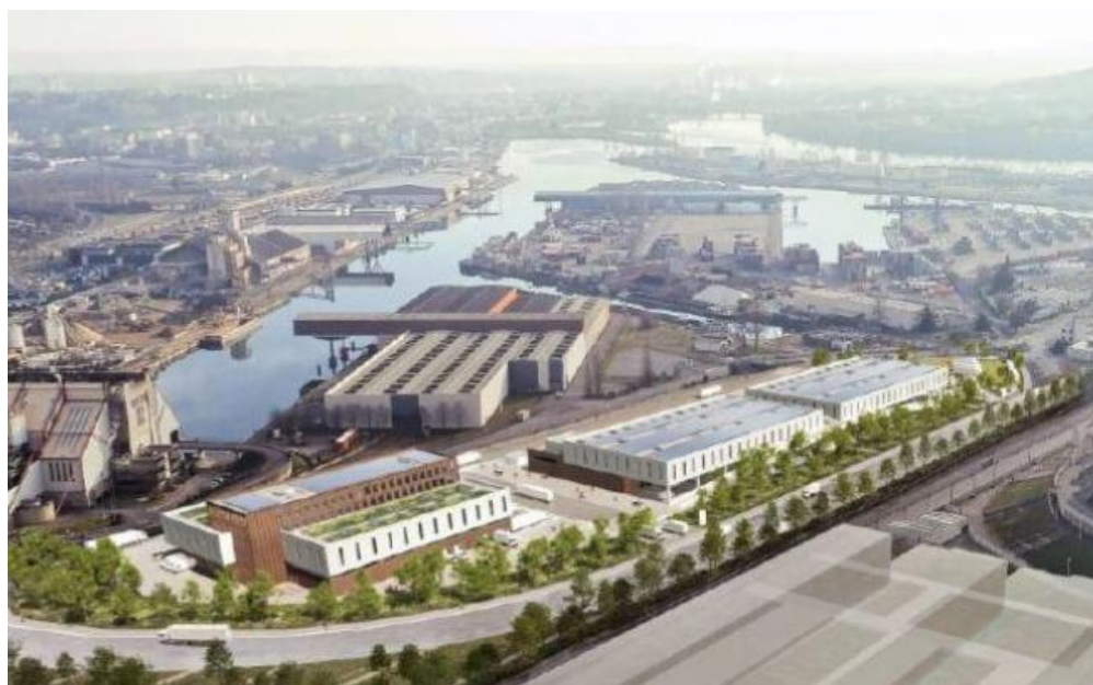
L'inauguration de l'Hôtel de logistique urbaine de Lyon est prévue le 25 mars sur le port Édouard-Herriot. Photo LPA
